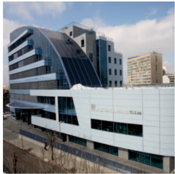
Риск Инженеринг, гр. София (фотоволтаична система)
